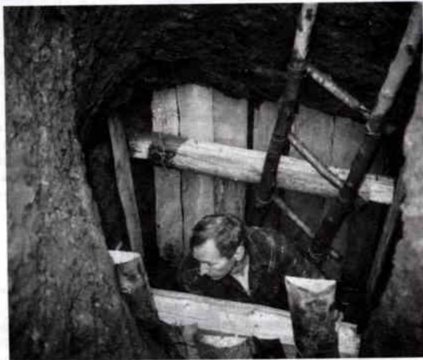
Res beim Einschalen.
