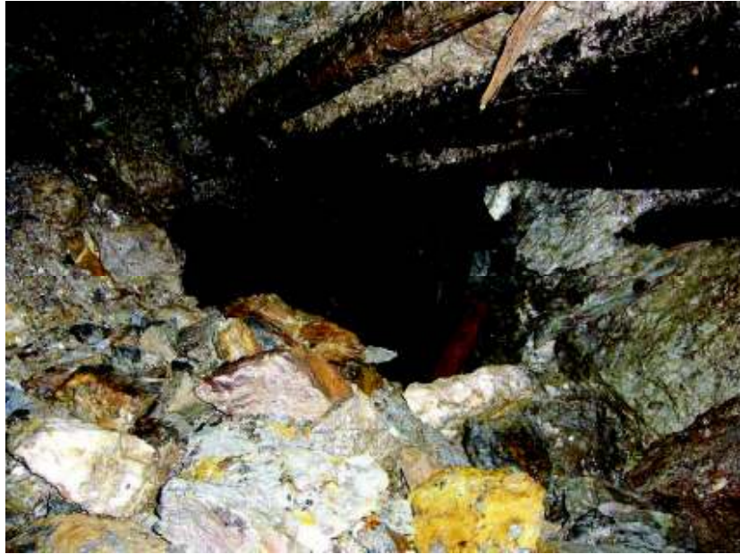
Abbildung 5: halb verstürzter Stollen im Abbau B, Einsturzgefahr!
