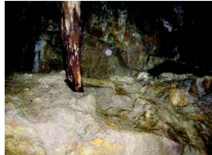
Abbildung 7: Holzstütze und Mauer, mitten im Abbau B
